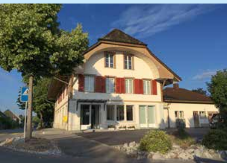
Ehem. Schulhaus Heimenhausen Seit 2014 Gemeindeverwaltung
