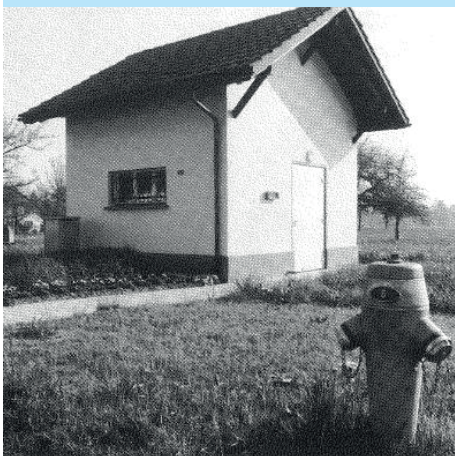
1958 erbaut, 1989 renoviert: das Pumpwerk Niederönz
