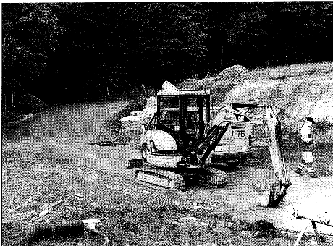
Freie Sicht statt Strassenunterführung: Die Bauten der früheren Buchsibahn in Wanzwil werden gegenwärtig abgebrochen und eingeebnet.
