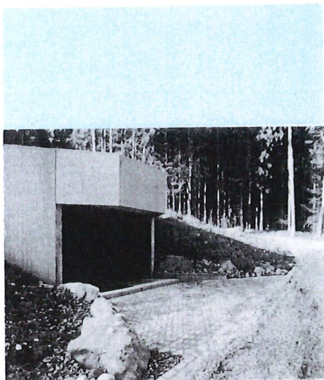
Reservoir Schlosswald nach Bau- vollendung 1987/88
