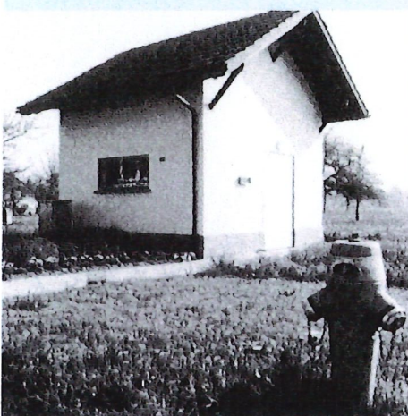
1958 erbaut, 1989 renoviert: das Pumpwerk Niederönz
