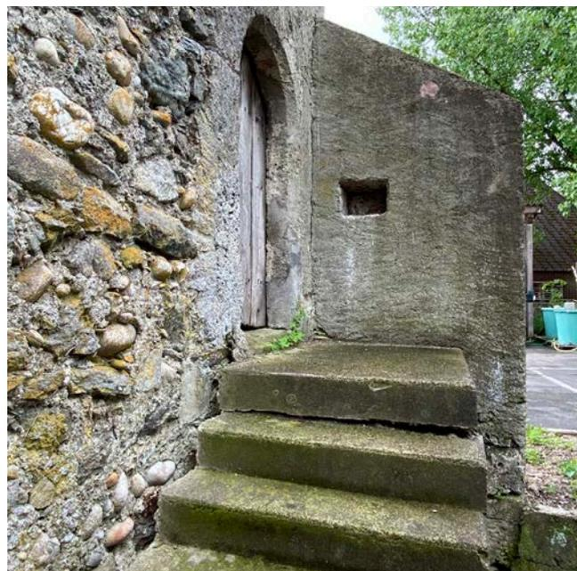
Zudem sei wichtig, dass keine Anbauten, Treppen u.a. direkt mit der Mauer verbunden seien und kein Teerbelag an die Mauer grenze. Somit musste das kleine Fenster des Archivs, das mit Zement eingefasst war, sowie alle mit Zement ausgebesserten Stellen der Mauer, saniert werden. Der Teerbelag wurde etwa 10 cm um das Gebäude entfernt und mit Kies ersetzt, damit das Regenwasser versickern konnte.
